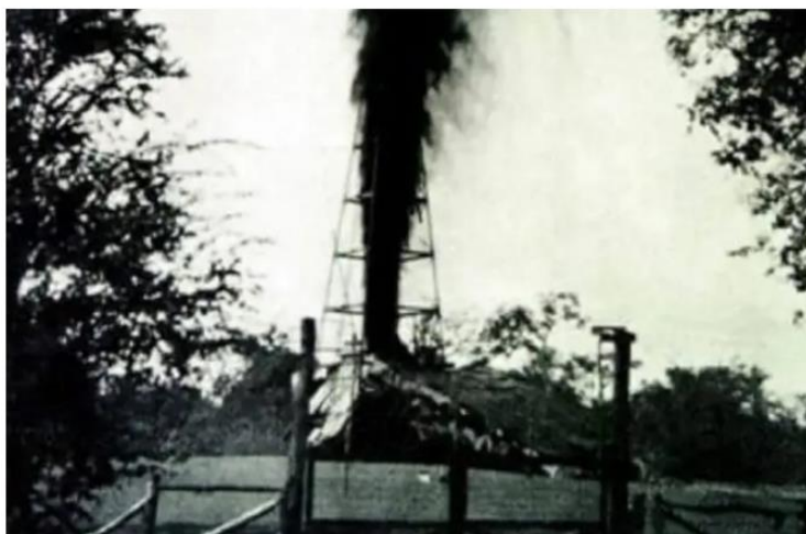
Figura 1. El primer pozo petrolífero de Venezuela en 1922. Se estimó que arrojaba 100 mil barriles diarios de petróleo [5]. Este petróleo fácil de extraer ya se está agotando.
